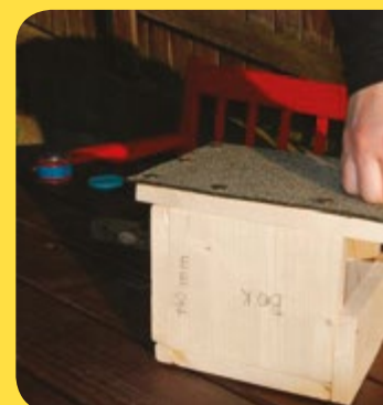
13 Pomocí připínáček na střechu přiděláme asfaltový papír.
